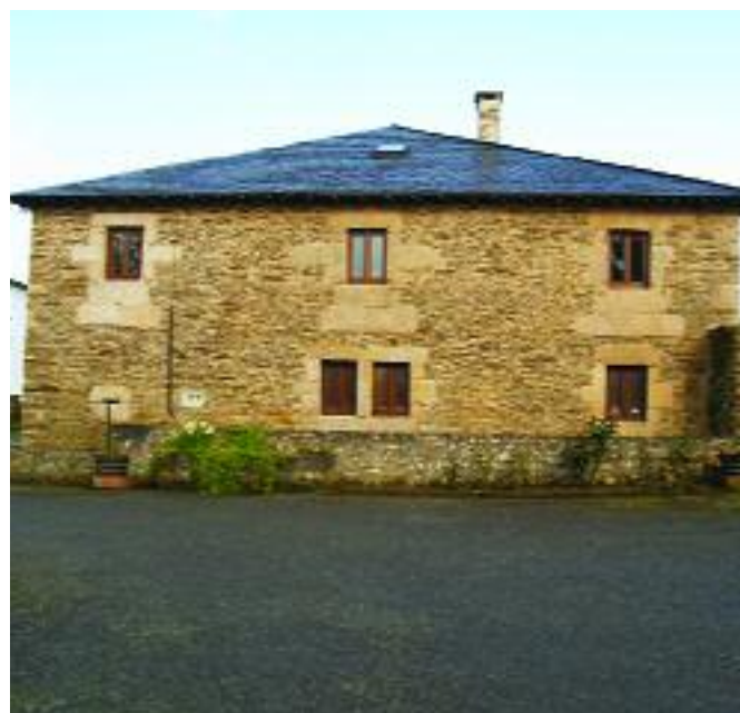
Casona en restauración, Farnadeiros
