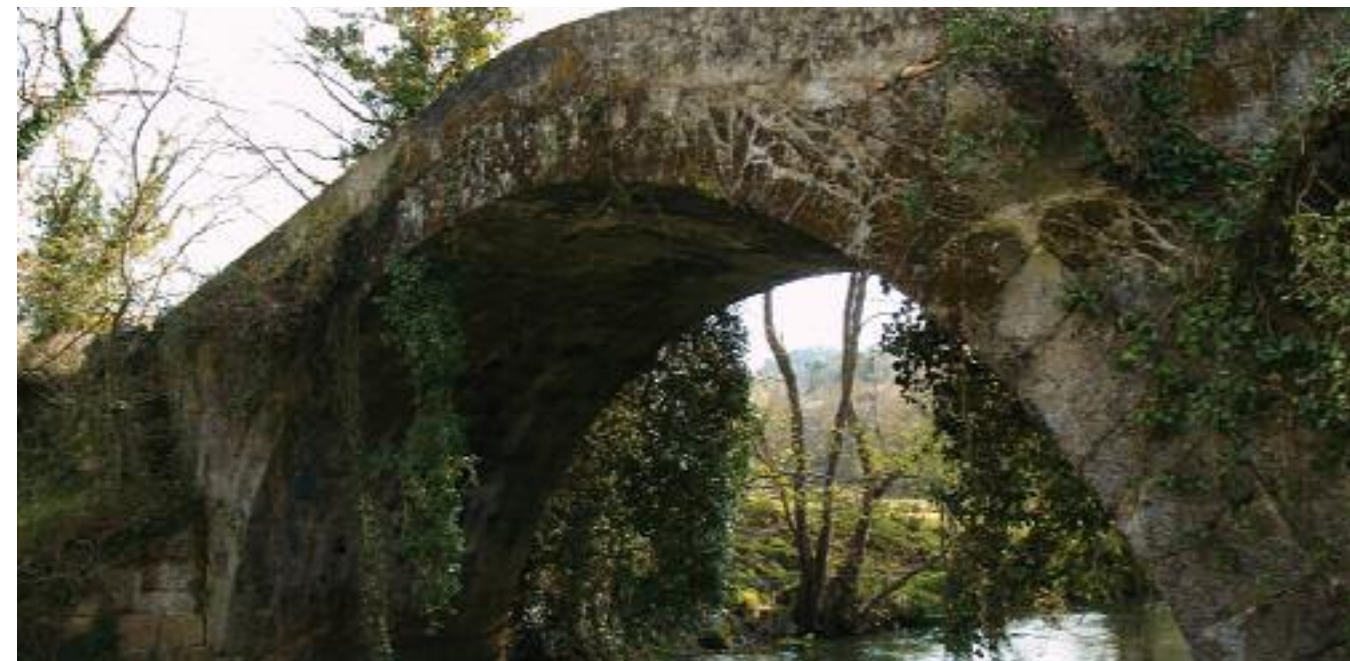
Ponte do Lago
