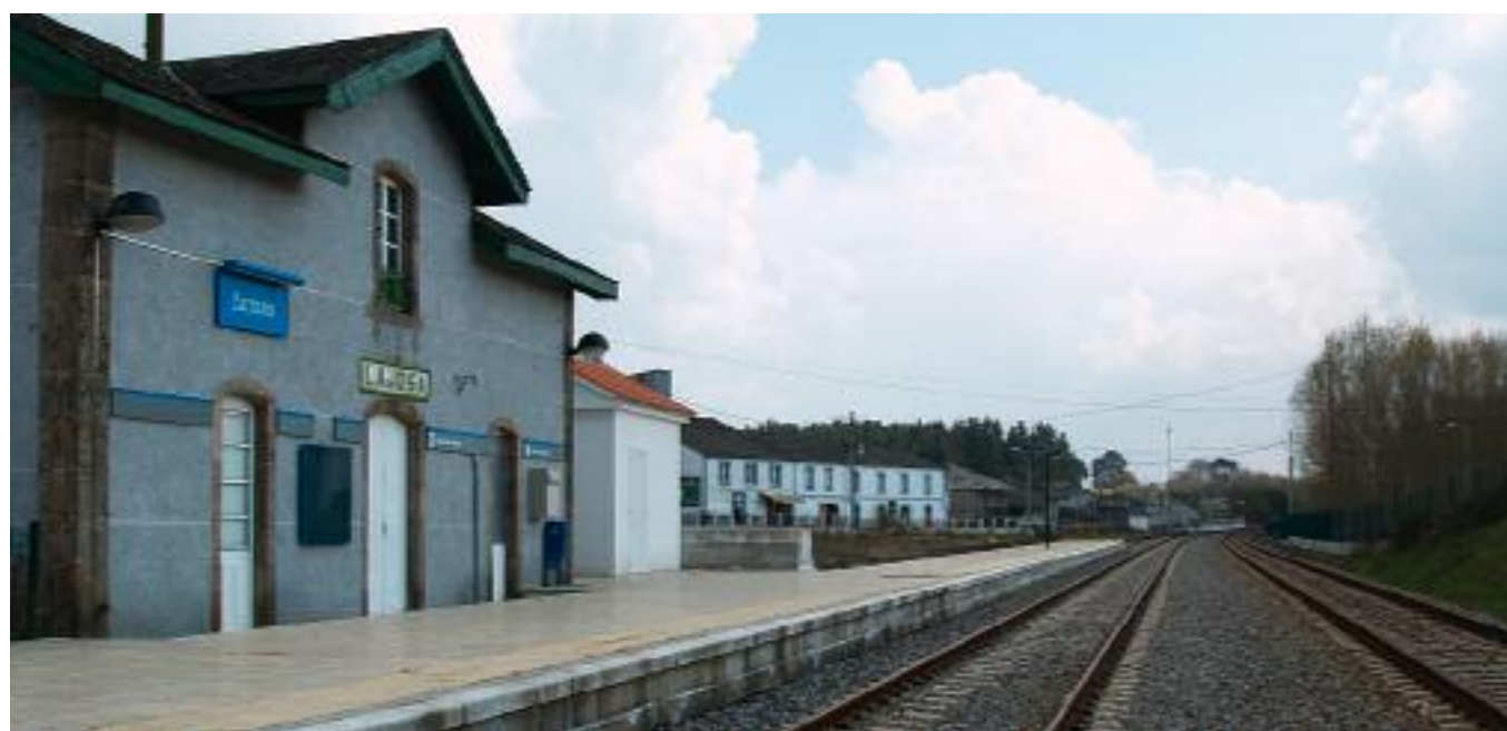
Estación de Laxosa
