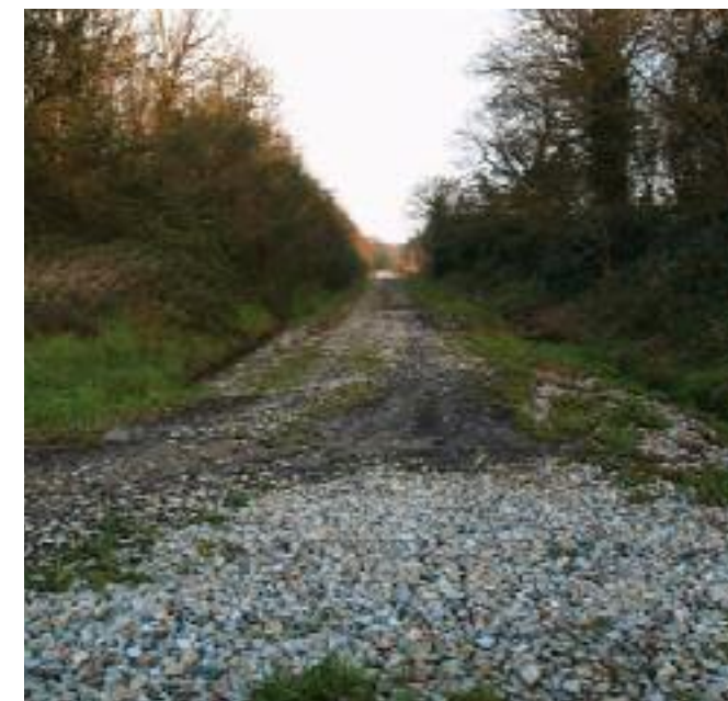
Variante de Bocelo. Desvío da vía férrea
