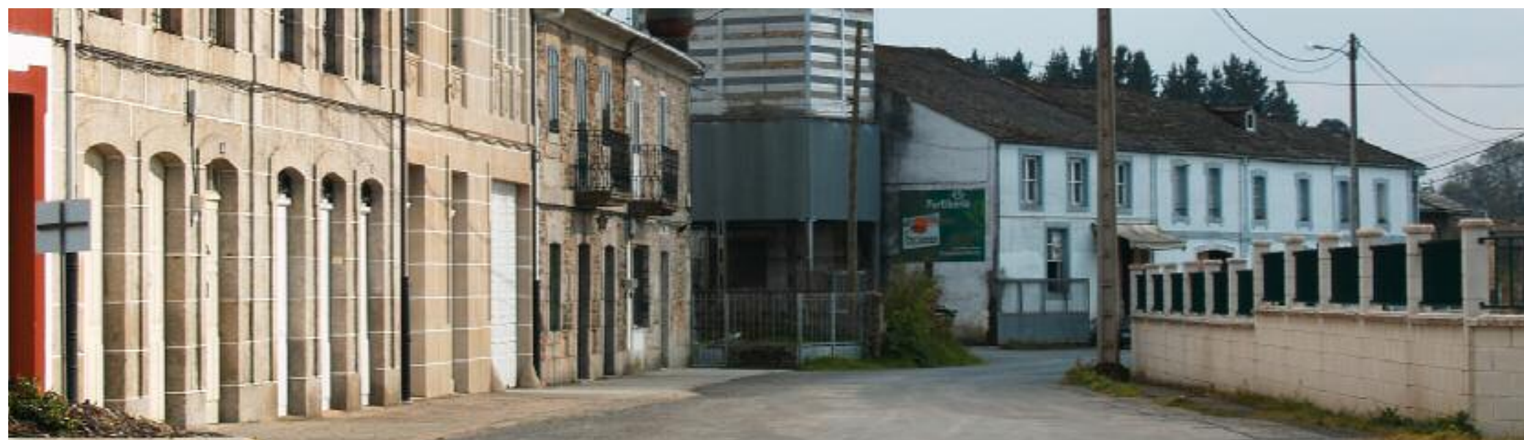
Casas Estación de Laxosa
